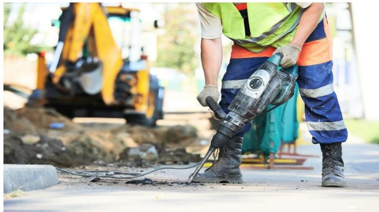
**Slika 9.** Primjer izvora vibracija pri radu s pneumatskim strojem
